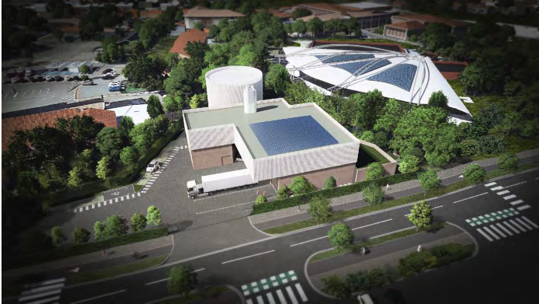
Chaufferie biomasse- appoint/sécurité
