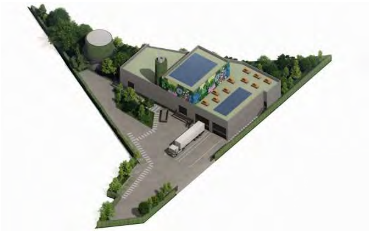
Chaufferie biomasse- appoint/sécurité
