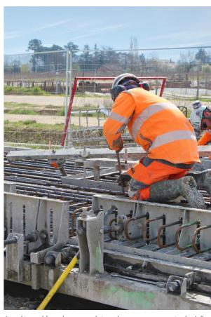
Appelée « tablier », la structure béton du pont est composée de dalles également en cours de fabrication sur la zone chantier.
