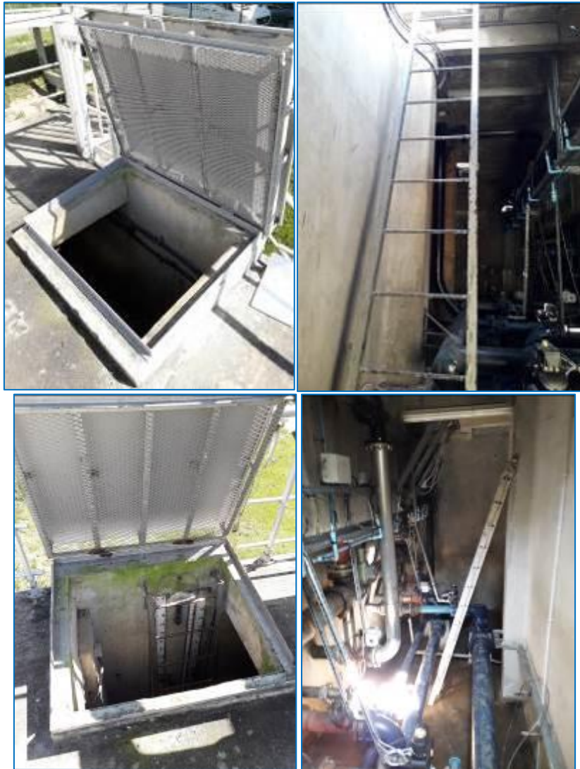
Accès à la galerie des filtres à sable
